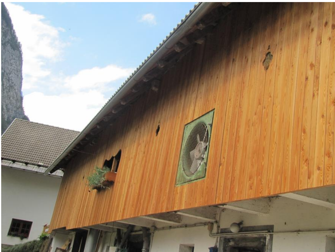
Investicijsko vzdrževalna dela (foto:Tatjana Grilc)
